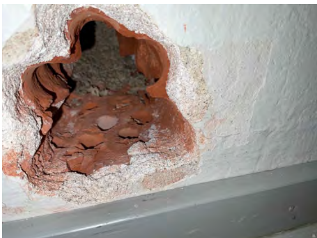
Tasoitteen ja tiilen taustalla lastuvillalevy eristeenä
