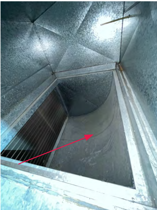
Kuva 4. Ilmakammiossa hiukan pölyä
