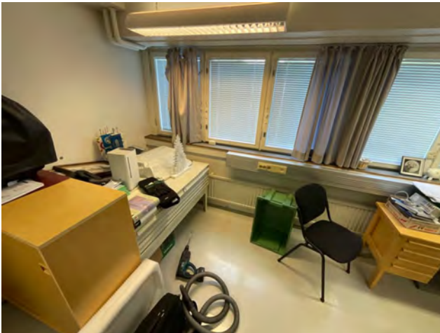
Rakenneavaus 9, toimiston ulkoseinä
