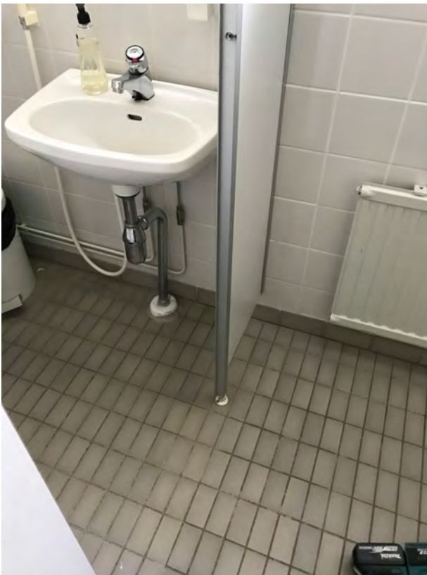
Rakenneavaus 7: WC/N ulkoseinä
