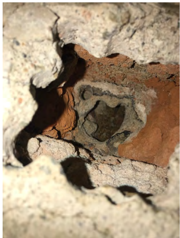
Alemman betonilaatan alla hiekka
