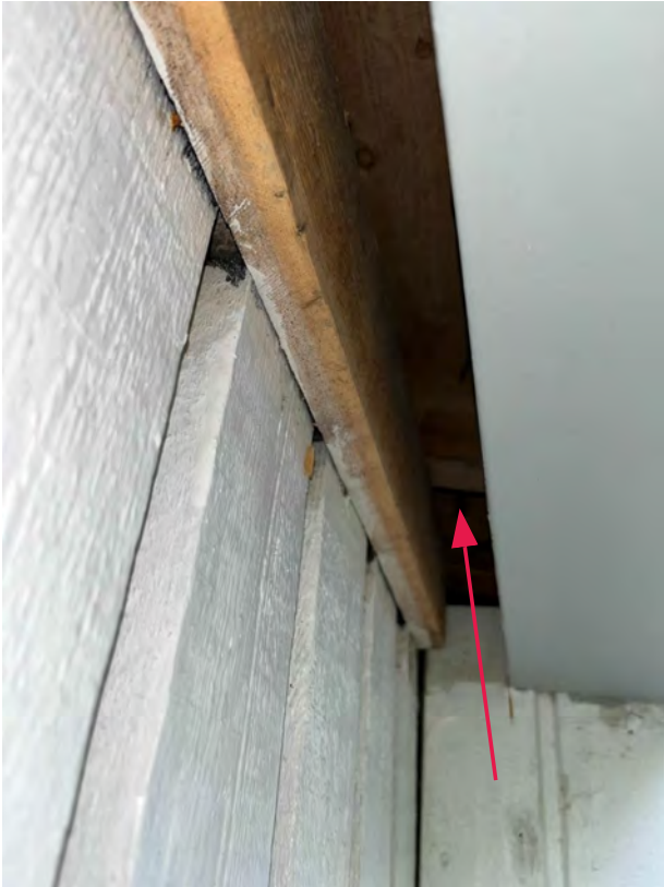
Kuva 33. Tuuletusreitti (huone nro 10, aula)
