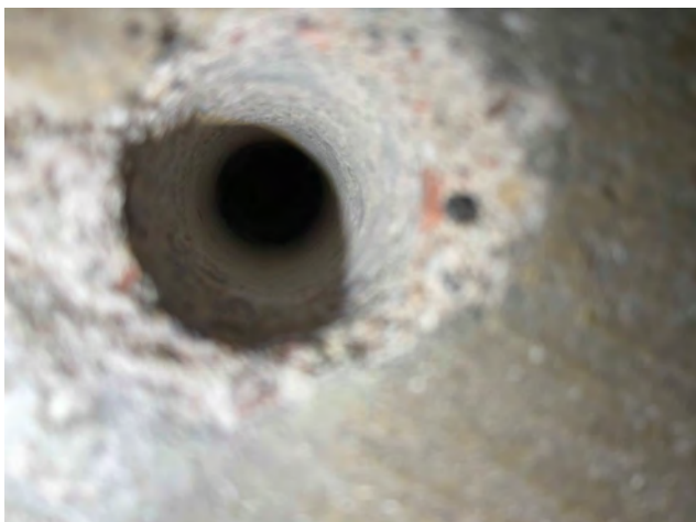
Alapohjassa EPS-eriste valun alla
