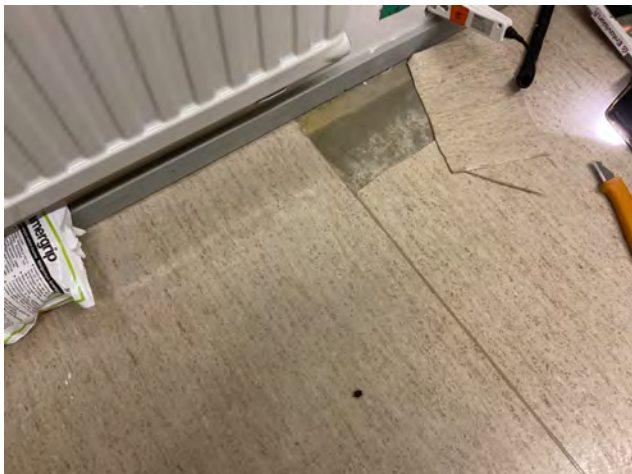
Rakenneavaus 5 varaston alapohja
