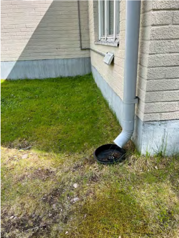
Kuva 17. Yksi sadevesikaivo havaittiin
