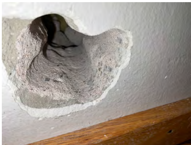
EPS-eristeen kosteus 62%. Noin 180mm betonia sisäkuoressa
