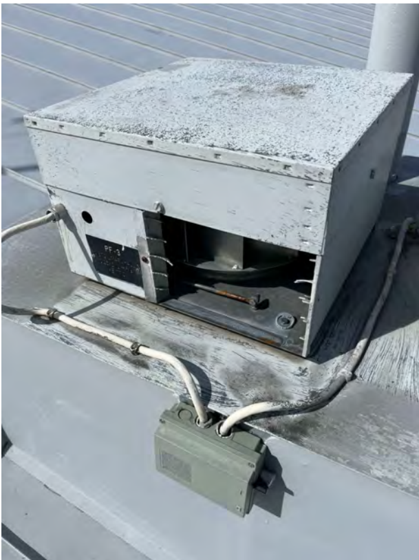
Kuva 27. Huippuimurin säleikkö rikki
