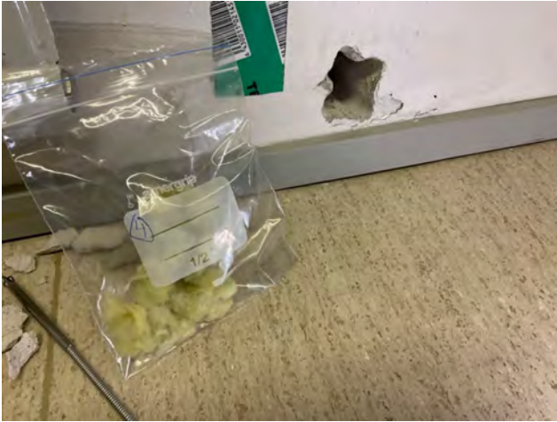
Mikrobinäyte 4 varaston ulkoseinän mineraalivilla
