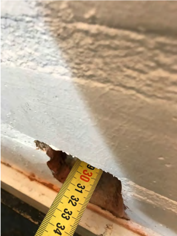
Tiilimuurauksen paksuun ennen eristetilaa noin 300 mm
