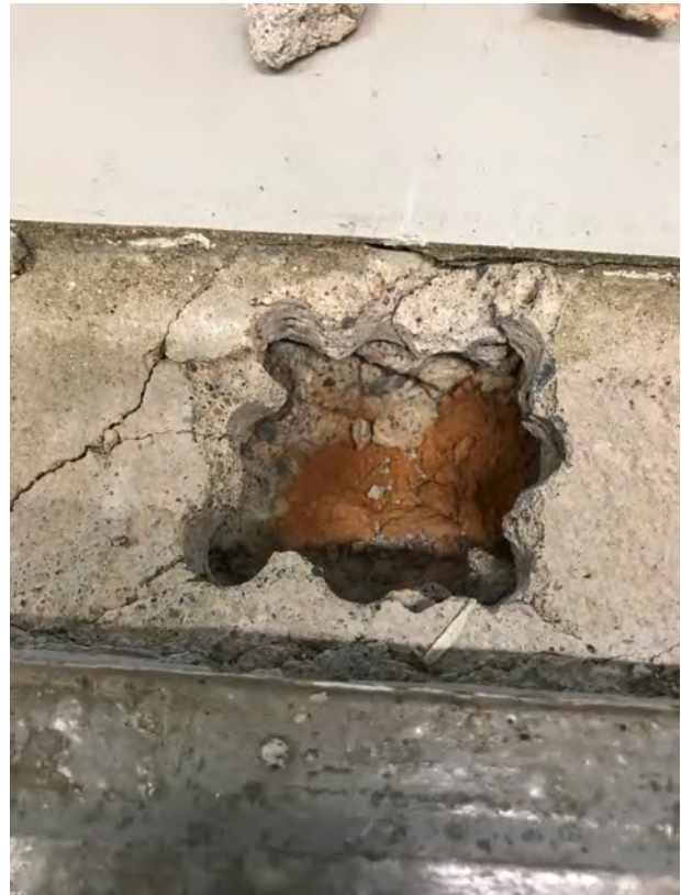
Betoni-laatan alla tiilimuuraus.
