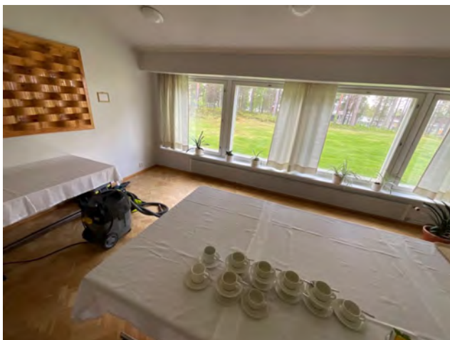
Rakenneavaus 3: Kattaushuone ulkoseinä
