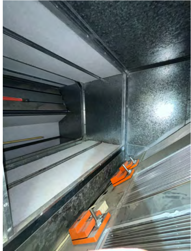
Kuva 3. Ilmanvaihtokone puhdas
