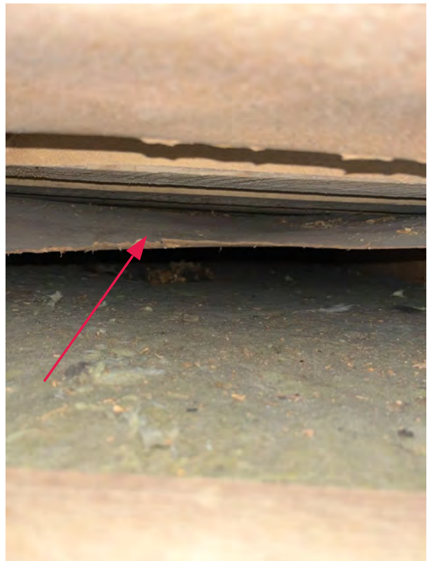
Kuva 32. Aluskate päättyy eristetilaan (huone nro 10, aula) .
