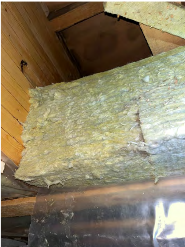
Kuva 31. huone nro 24 yläpohjaa
