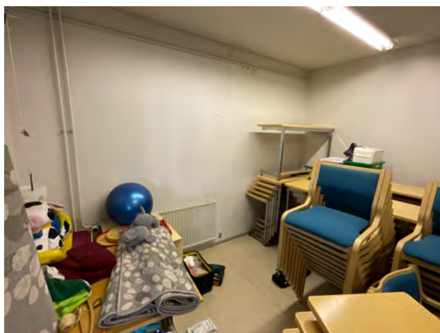
Rakenneavaus 4: ulkoseinä ja varasto
