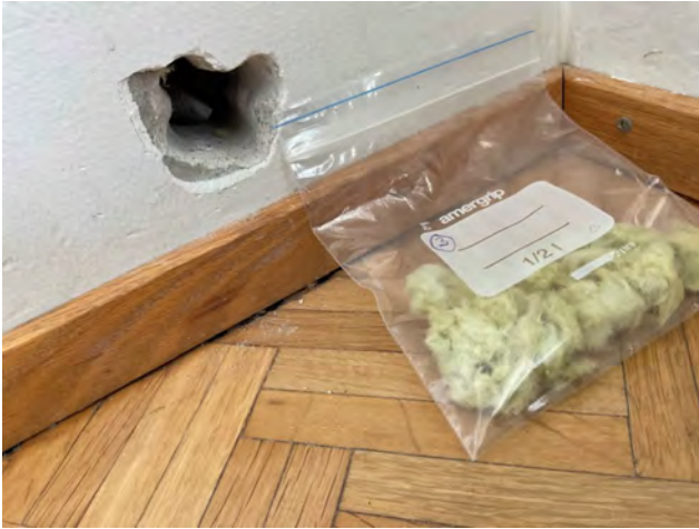
Mikrobinäyte 3, ulkoseinän mineraalivilla
